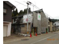
←改装中の KS☆HAUS
